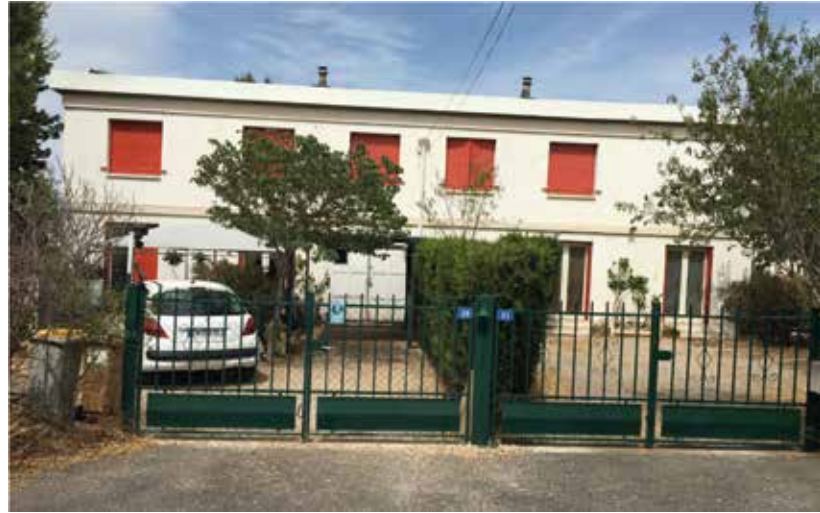
Photo 1 - La résidence Concorde : vue d'un des 13 blocs de quatre logements
