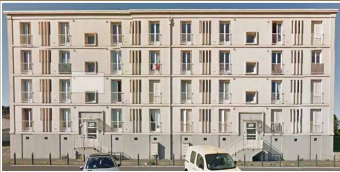
Photo 4 - La résidence Les Douanes après les travaux. L'étape du témoin a permis d'optimiser le phasage pour assurer la sécurité de ces travaux réalisés en site occupé.
