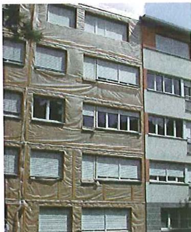
Pose des panneaux bois
