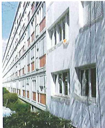
Pose de l'isolation extérieure Intérieur avec parement
